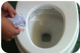
Posez un chiffon humide sur le détecteur de présence du siège pour procéder aux tests
